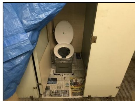
内開きの扉で閉まらない場合はビニールシート活用
