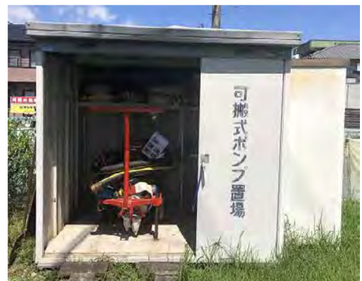
④ 多呂公園内 可搬式ポンプ置場倉庫と可搬式ポンプ
