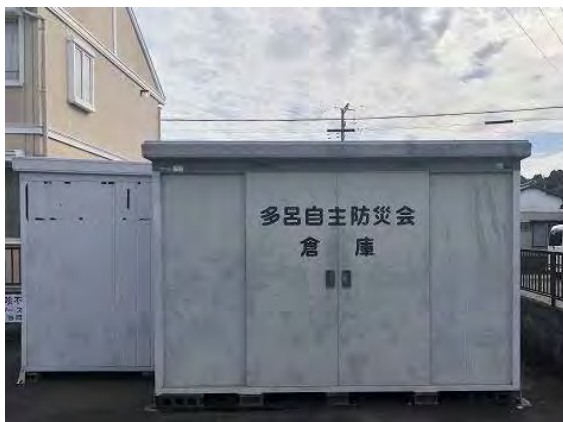
③ 多呂公園内 多呂自主防災会倉庫
