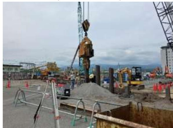
図：H鋼材周囲の埋め戻し状況
