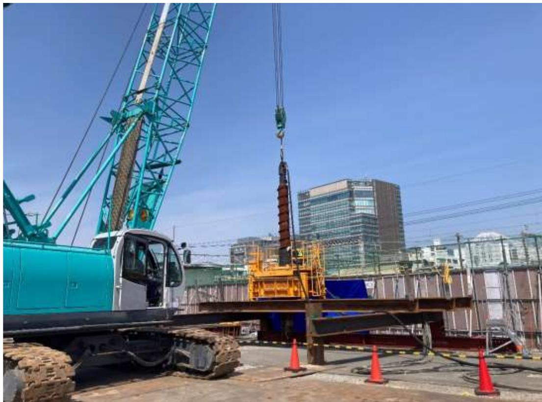
図：ARハンマ工法による山留め工事の施工状況
