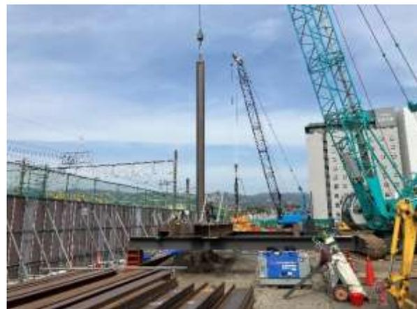
図：H鋼材の打設状況
