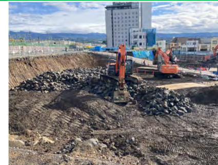
土工事の様子 (A棟)
