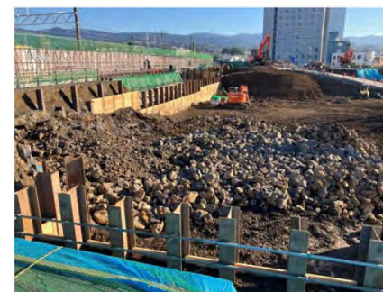
溶岩掘削 (A棟)
