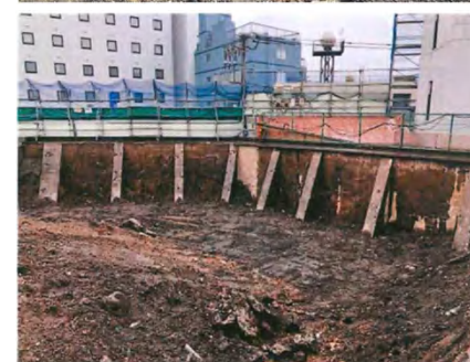
掘削後の様子 (C棟)
