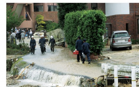
豪雨による被害
