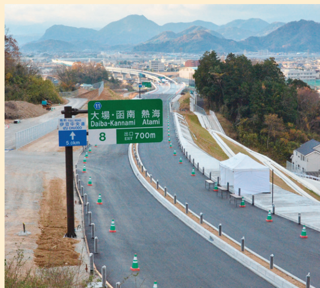
▲内陸を通る東駿河湾環状道路は、津波の影響を受けにくい
