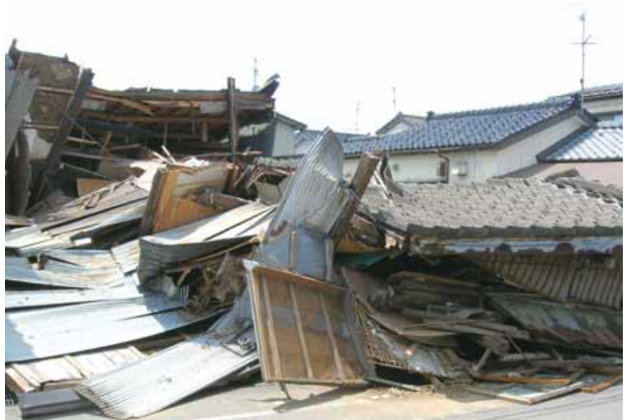
▲新潟県中越沖地震で倒壊した家屋
