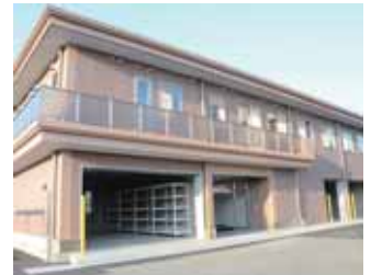
▲消防通信指令センター庁舎
