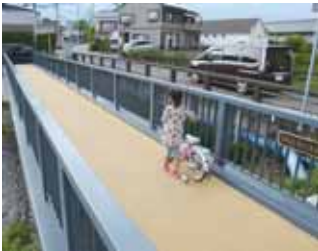
▲小山橋側道橋
