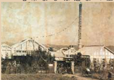
▲工場外観（昭和二年）
