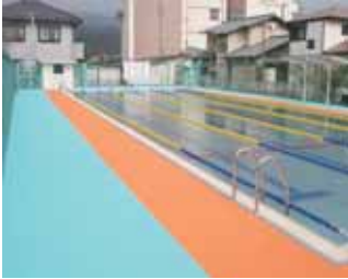
▲佐野小学校プール
