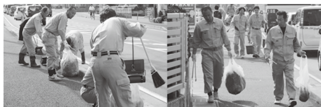
▲作業中の様子
