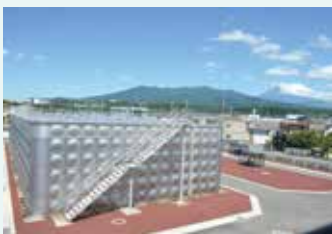
▲伊豆島田浄水場
