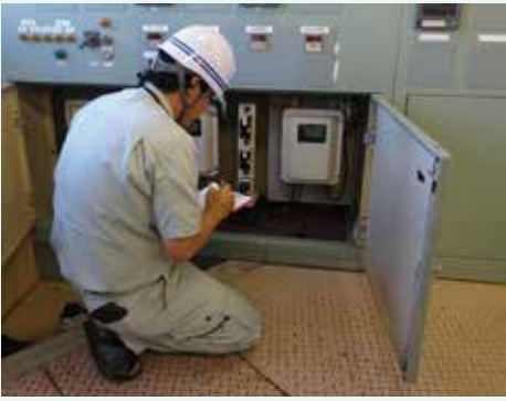
▲計測設備の点検中
