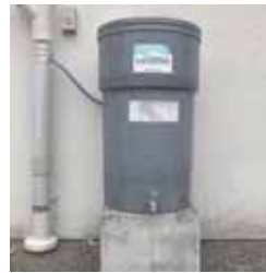
雨水貯留施設
