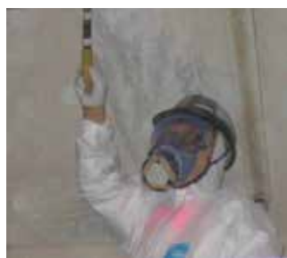
▲吹付けアスベスト除去作業
