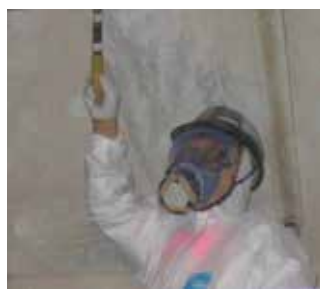
▲吹付けアスベスト除去作業
