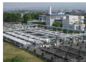
▲浄化センター
