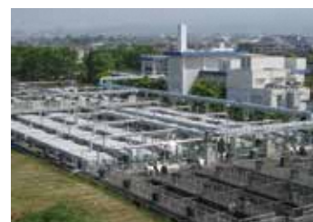
▲浄化センター
