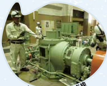
雨水ポンプ場の点検
