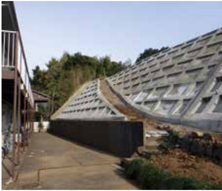
▲急傾斜地崩壊防止対策事業
