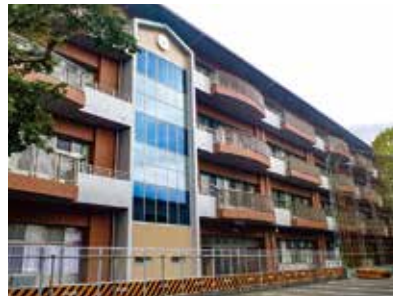
▲北中学校南校舎の改築は、平成30年度で完了しました。
