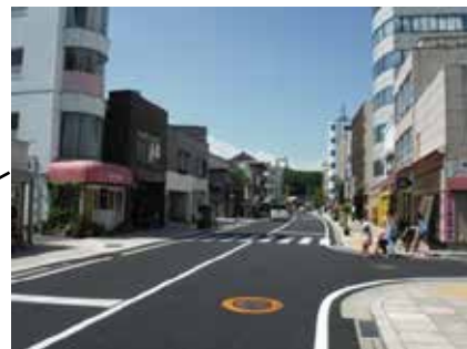
▲無電柱化後の芝町通り
