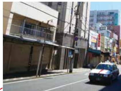
▲無電柱化前の一番町工区
