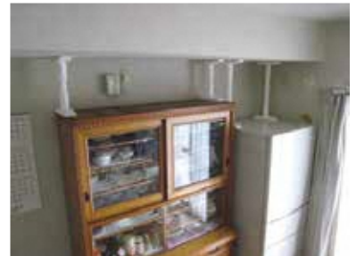
▲転倒防止器具の取り付け
