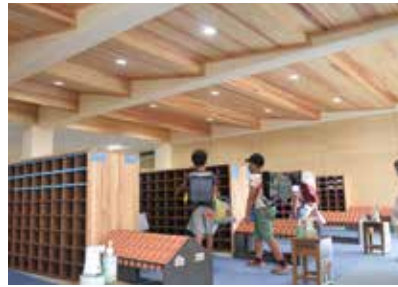
▲長伏小学校昇降口の改修 (各小学校施設補修整備事業で実施)
