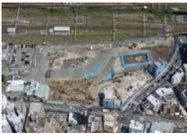
▲工事現場写真 (提供：三島駅南口東街区 A 地区市街地再開発組合)
