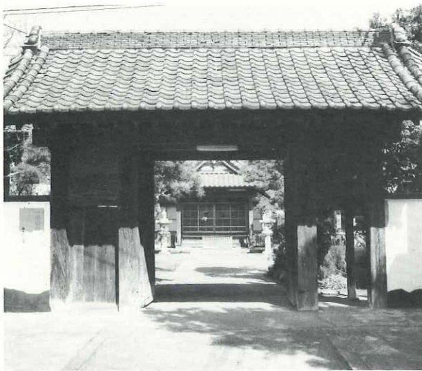
樋口本陣の門(現在円明寺山門)
