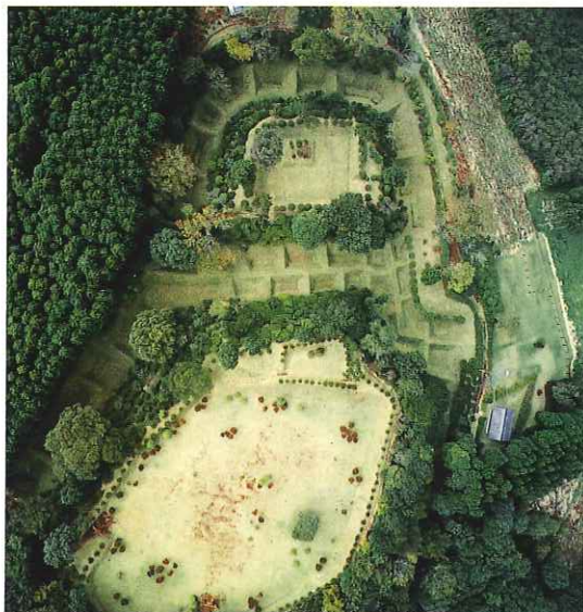
▲山中城 航空写真(上部より、西の丸、とり囲むように障子堀りがめぐらされる)
