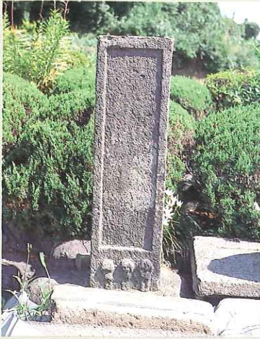
加茂川町 下神川橋 (延宝8年)1680
