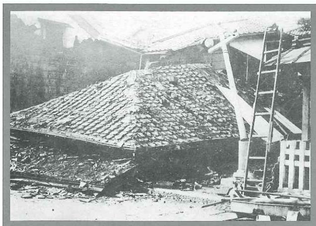
関東大震災の三嶋大社前家屋の倒壊(提供:沼津市明治史料館)
