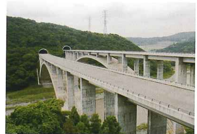
第二東名新富士川橋建設現場 平成19年(2007)
