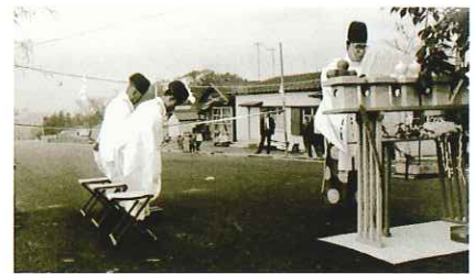
国道1号三島バイパス開通式 昭和39年(1964)
