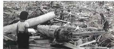
狩野川台風被害の様子
