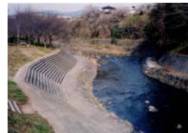
大場川鮎止め橋・020208.jpg
