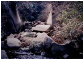
沢地川藁ヶ沢橋・020207.jpg
