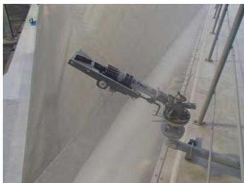
図 3-71 散水設備の事例
