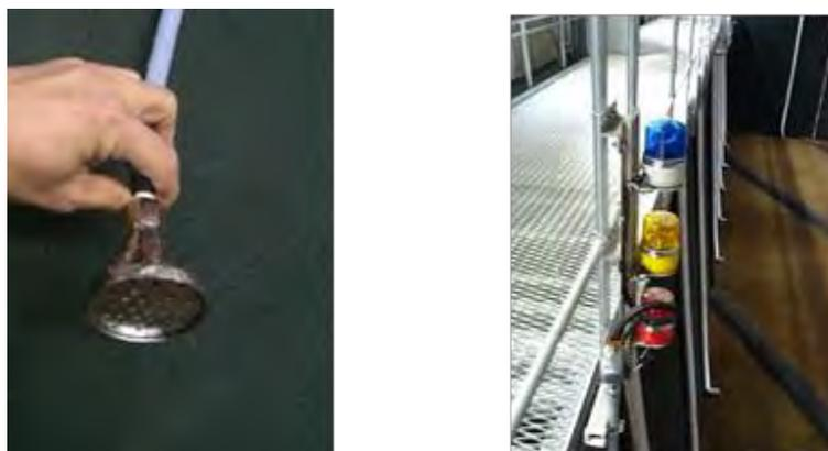
図 38 ガス検知設備の事例
