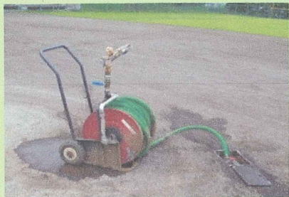
散水栓を設置しました
