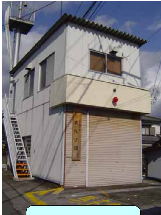
第8分団 (建替え予定) 建設から30年経過
