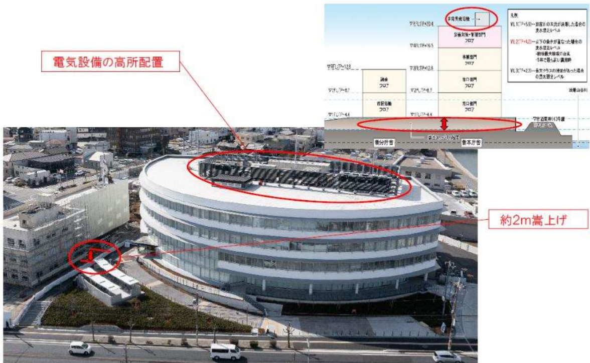
高砂市新庁舎建設
