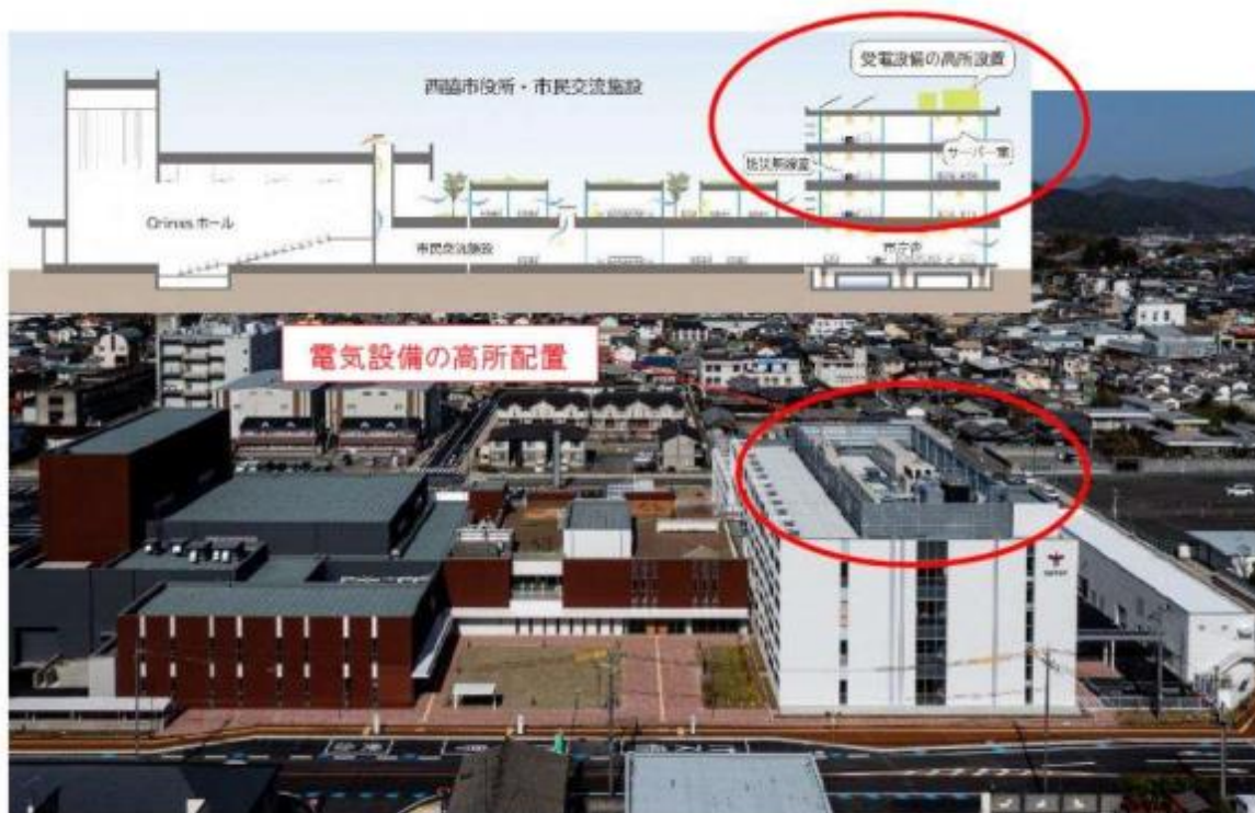
西脇市新庁舎建設
