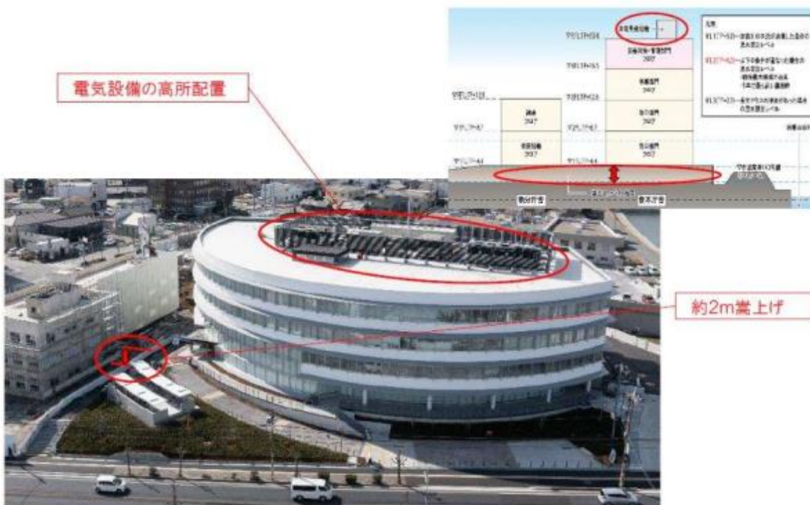
高砂市新庁舎建設
