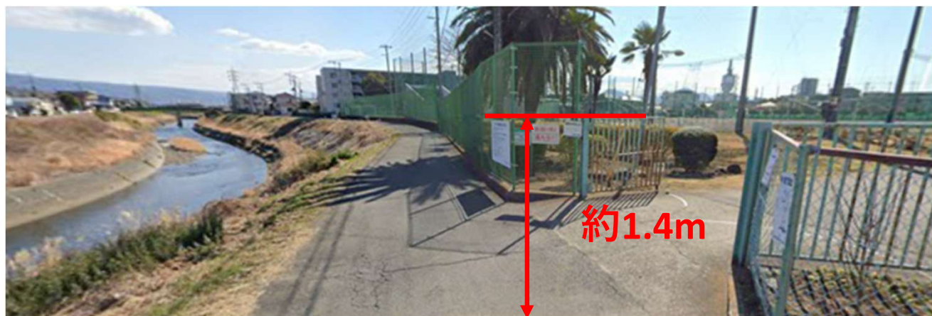
大場川の南二日町広場側の現況
