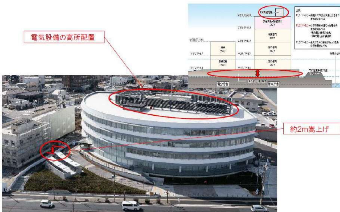
高砂市新庁舎建設
