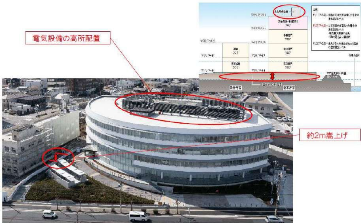
高砂市新庁舎建設
