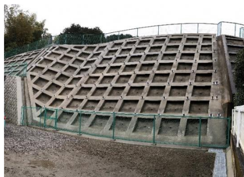
▲急傾斜地崩壊対策工事
