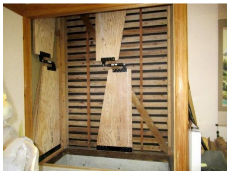
▲耐震補強工事の一例
