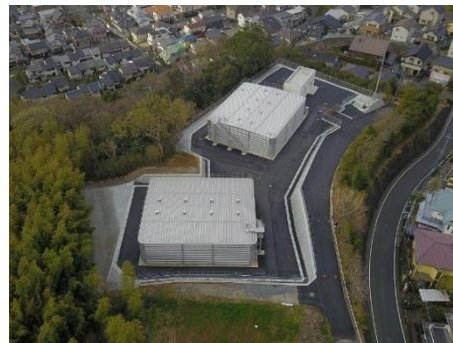
▲ 高区配水場（完成）
