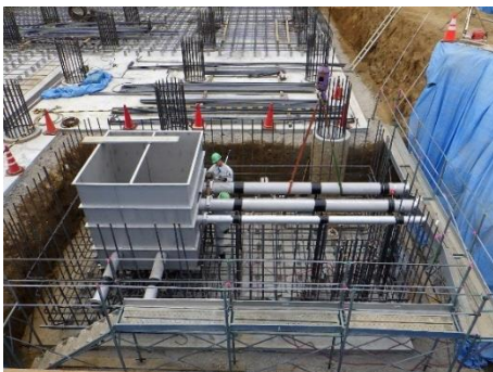
▲ 高区配水場配水池（施工中）
