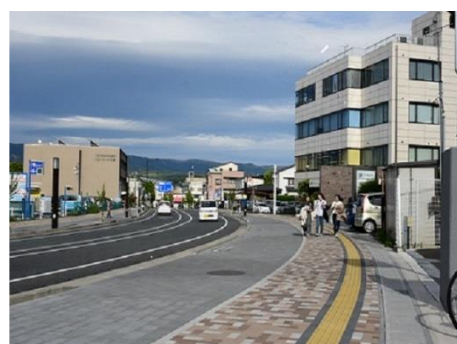
▲無電柱化の取組（下土狩文教線）
