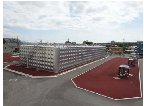
伊豆島田配水池
