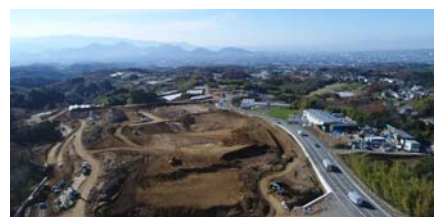
三ツ谷工業団地計画地 造成工事写真
