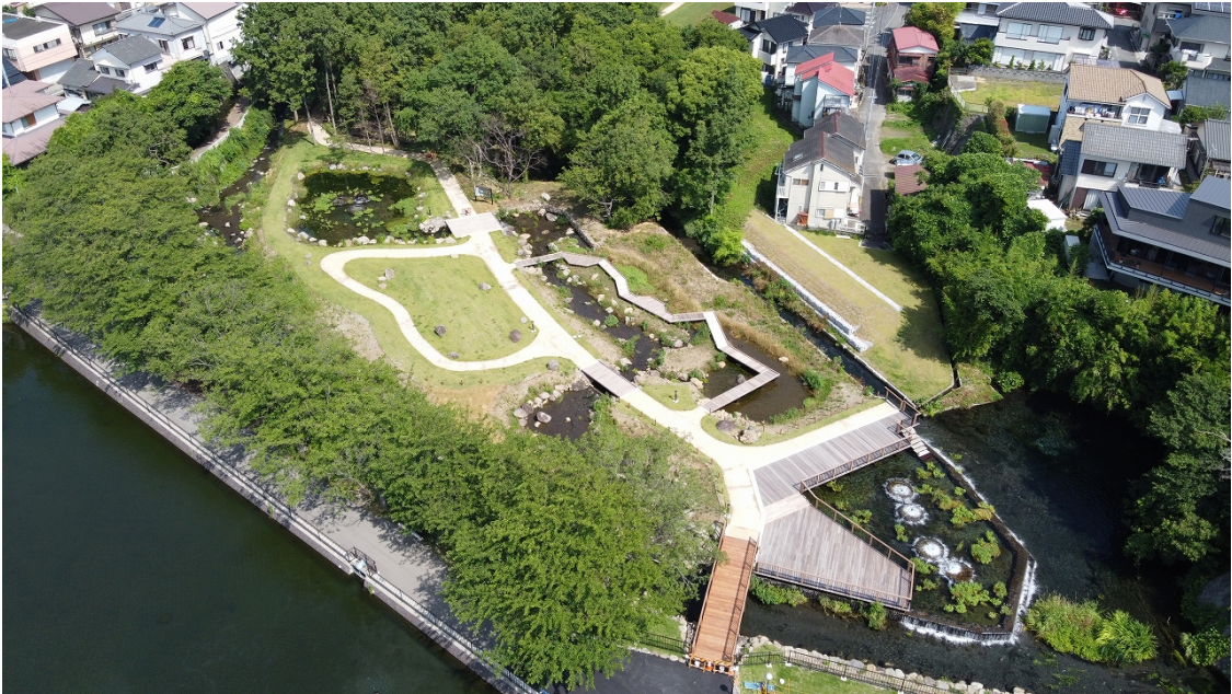
拡張整備が完了「境川・清住緑地」
