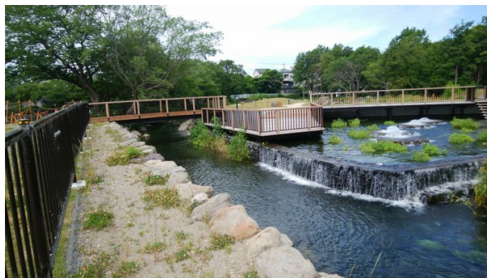
整備後の様子
