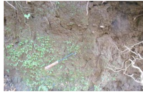
③ 沢部に堆積する未固結堆積物 火山灰起源の砂質シルトで、わずかに礫を含む。
