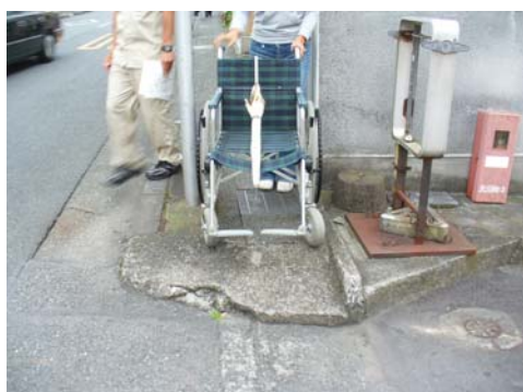
車椅子での通行も点検してみました。
