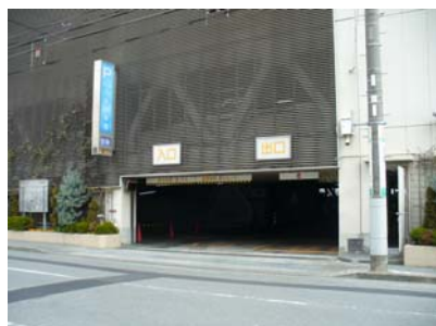
(三島市営中央駐車場)
