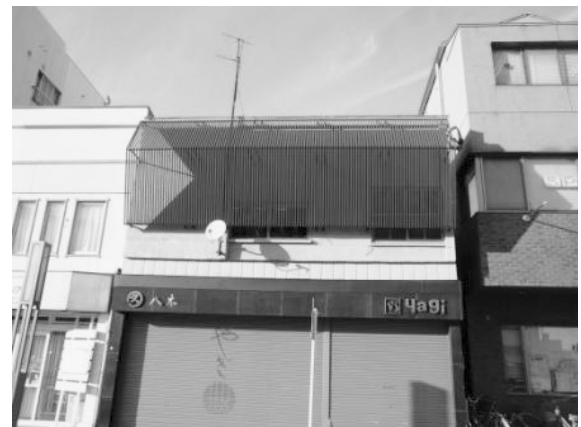
金属製の格子で建物ファサードの不要な部分を隠す
