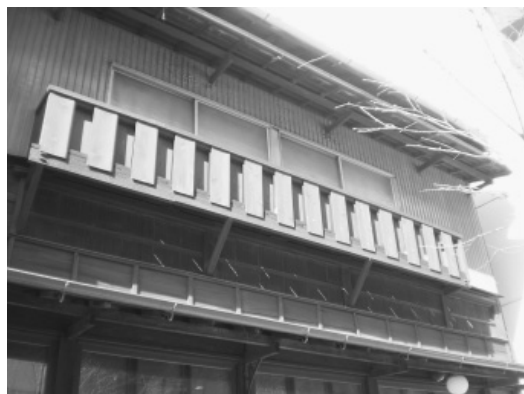
腰掛窓と手すり
