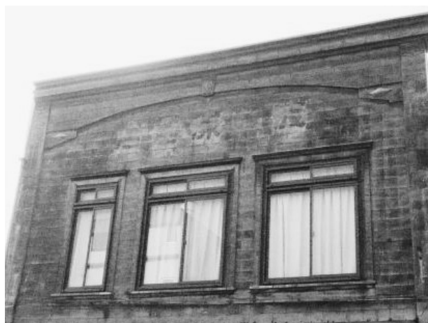
外壁が銅板で仕上げられた看板建築（現存）
