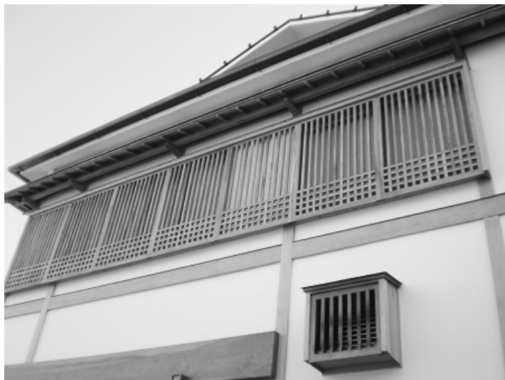
既存窓を格子により隠し、趣を醸し出している。 （既存改修）
