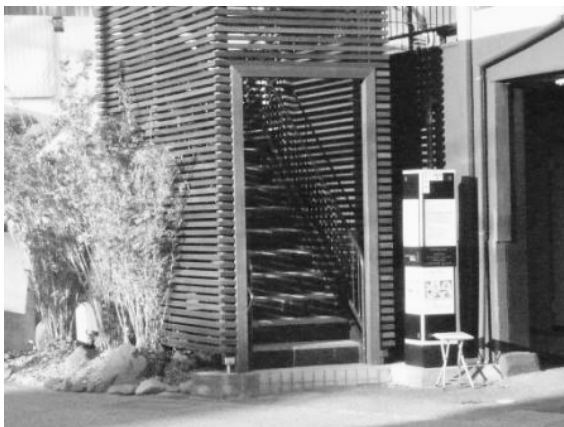
木製横格子で鉄骨階段を隠し外観を整える
