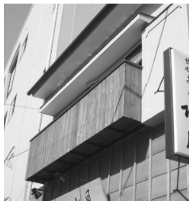
腰掛窓と手すり
