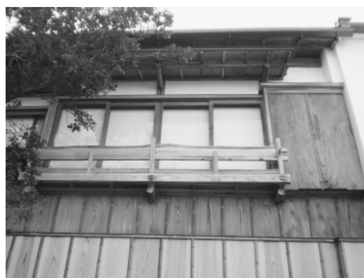
肘掛窓と手すり
