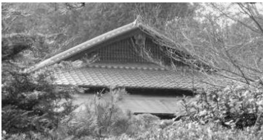
いぶし瓦、銅板による二軒
