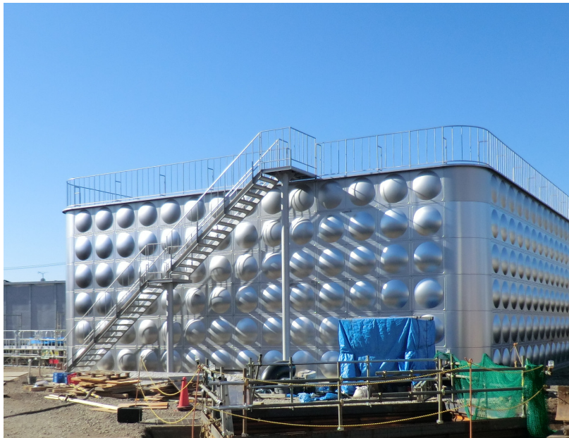
図 2-8 伊豆島田浄水場 新設配水池(施工中)
